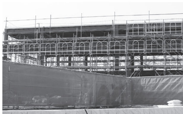
建設が進む消防本部新庁舎
